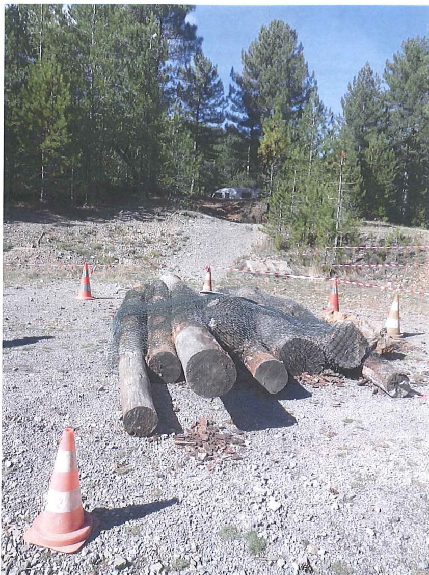
Photo 3 – Désordre d'octobre 2013 sur la commune de Saint-Félix-de-Pallières – mise en sécurité provisoire réalisée par la mairie
